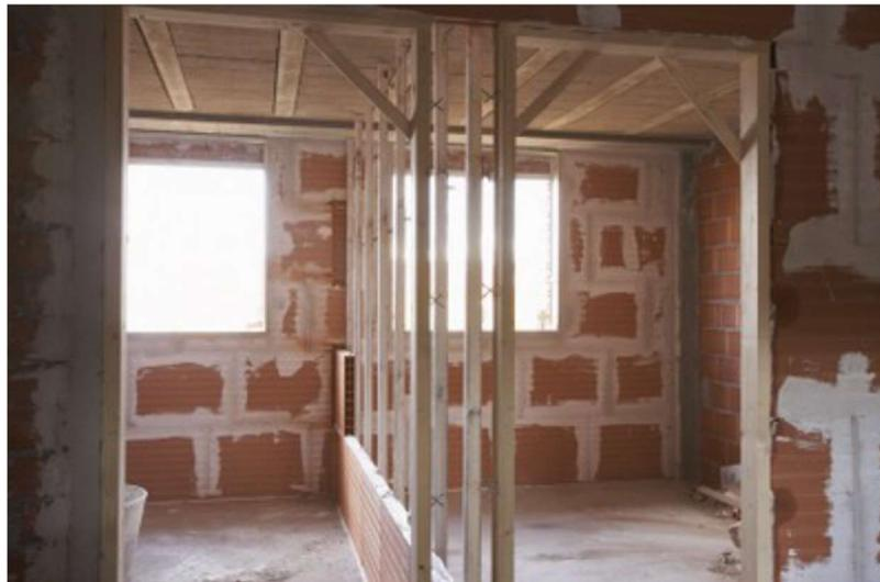
Las medianerías entre viviendas se realizarán mediante dos hojas de ladrillo cerámico acústico o similar y aislante entre ambas de 80 mm de espesor de lana de roca con revestimiento de yeso, o sistema similar que garantice las especificaciones del código técnico de edificación.
